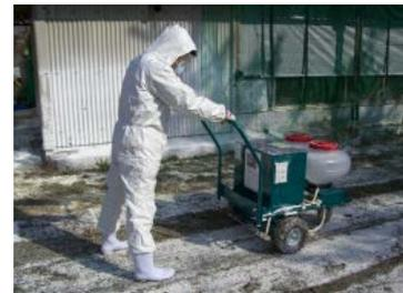
☆消石灰散布の前後に散水ノズルより水を散布することで、飛散を低減し路面への定着性を高めます。
